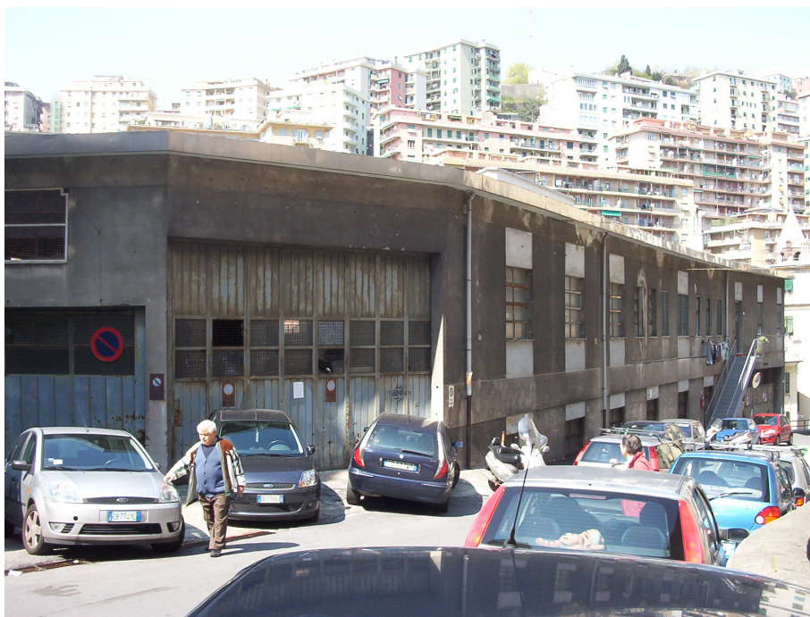
Foto 24 – Cannello di entrata e uscita autorimessa al quarto piano su V. Ponza
