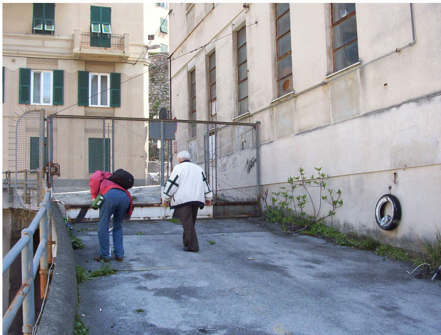
Foto 7 – Rampa di accesso al secondo piano da V. Ponza
