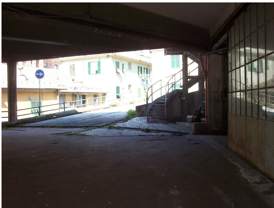
Foto 10 – Arrivo rampa di accesso al secondo piano da V. Ponza
