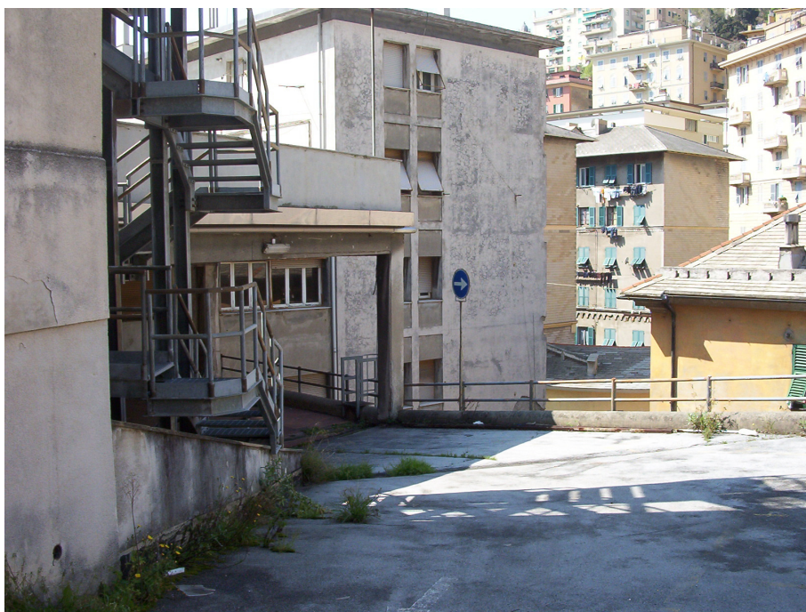
Foto 8 – Rampa di accesso al secondo piano da V. Ponza verso autorimessa Lateralmente - scala metallica di accesso al quarto piano
