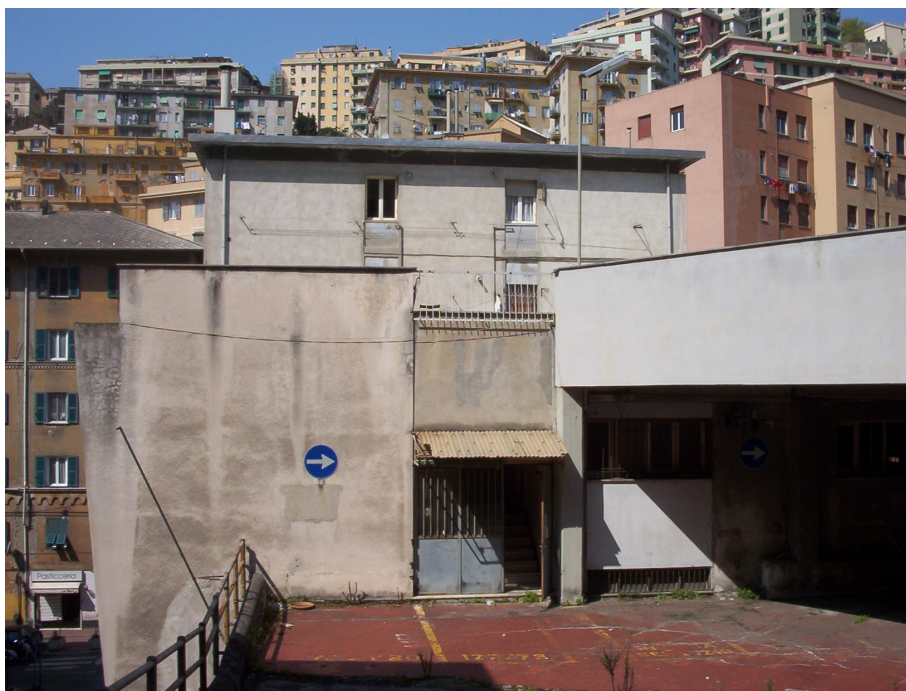
Foto 14 – Uscita dalla palazzina civile al secondo piano
