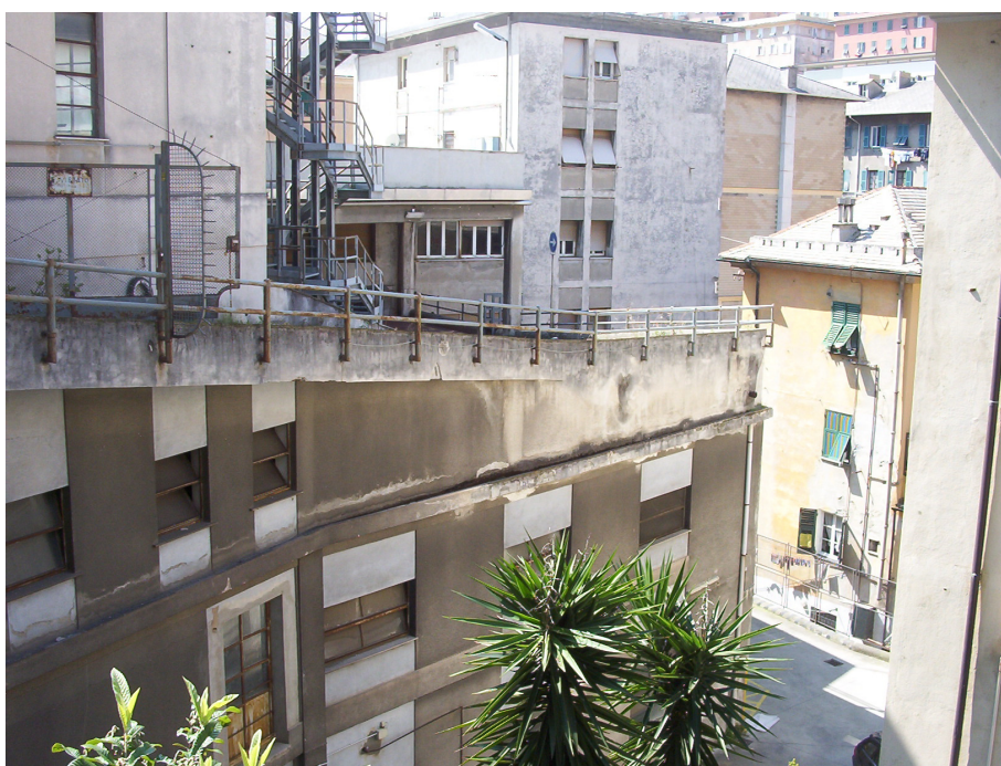
Foto 9 – Rampa di accesso al secondo piano da V. Ponza verso autorimessa con vista dei piani sottostanti la rampa
