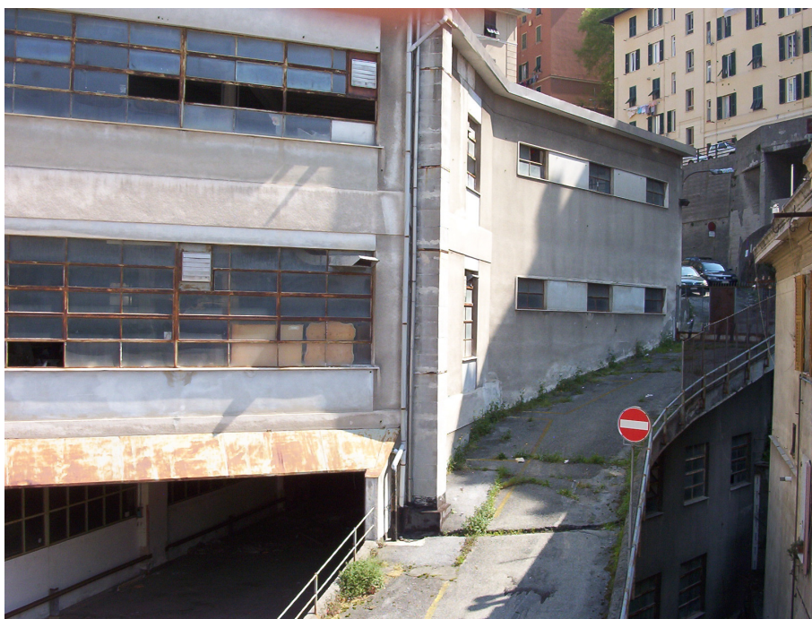
Foto 12 – Rampa di uscita dal secondo piano verso v. Ponza
