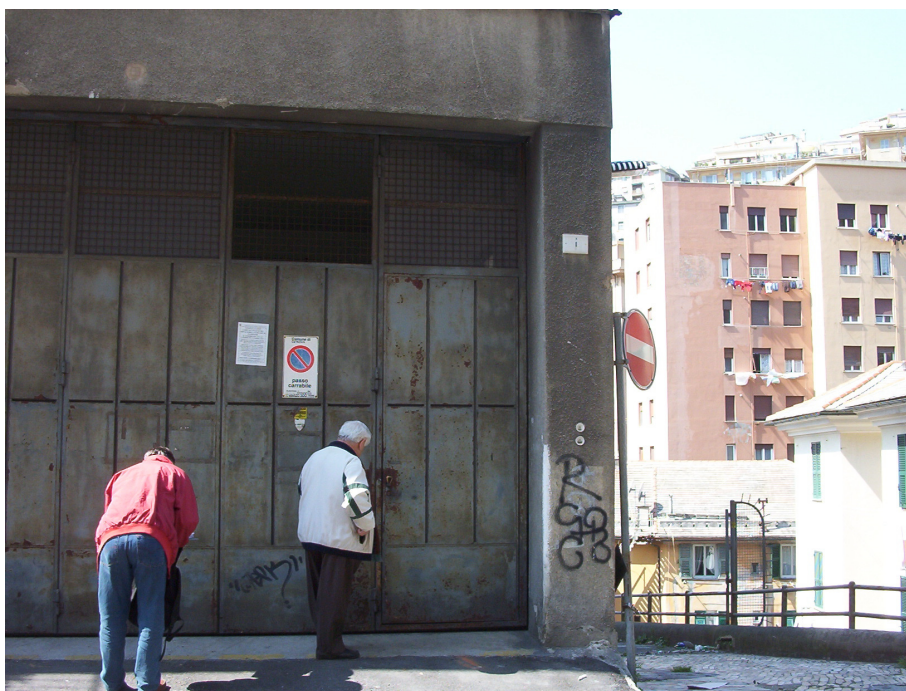
Foto 18 – Cannello entrata al terzo piano
