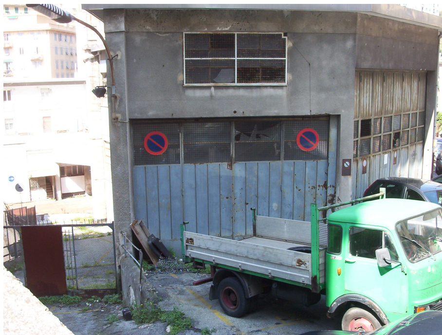
Foto 22 – In centro, uscita autorimessa del terzo piano, a sx, arrivo rampa di uscita dal secondo piano
