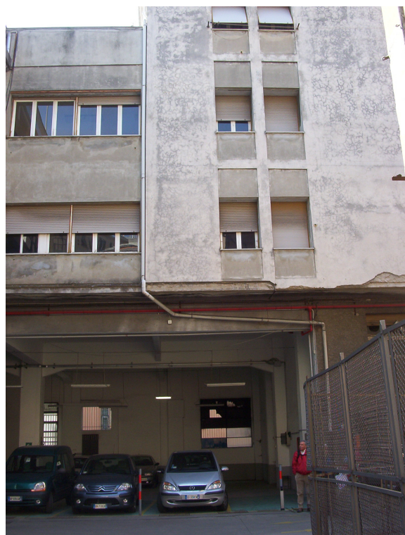
Foto 2 – Palazzina civile con parte dell'autorimessa al piano terra, sul lato ovest di V. Lagaccio
