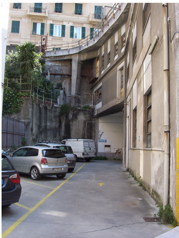
Foto 4 – Ingresso autorimessa da V. Lagaccio, lato nord
